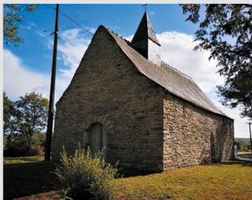
En août dernier, les membres de l'association ont enlevé le vieil enduit qui recouvrait la chapelle. Les anciennes maçonneries ont ressurgi dans toute leur splendeur.
